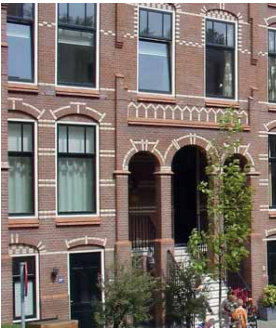
De vierde Haagse Obrechtsraat: nieuwbouw in oude stijl.
